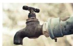
Mirabello Sannitico, sospensione flusso idrico il 15 settembre 2025
